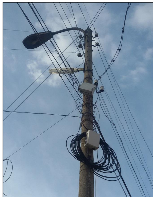
Снимка №1 Стоманобетонен стълб в гр.Каспичан
